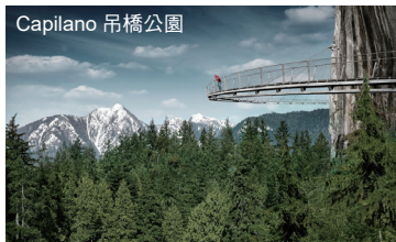
Capilano 吊橋公園
